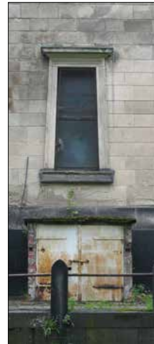
Fenster und Anbau an der Südfassade
