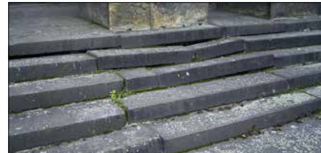
Treppe vor der Westfassade
