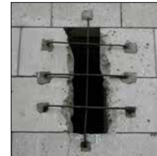
Wandöffnung in der Ostfassade
